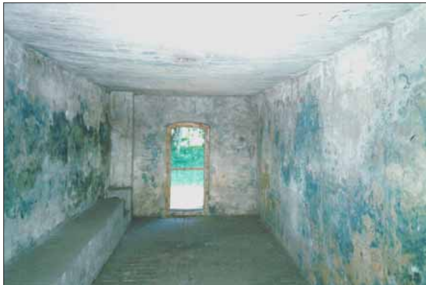
Oben: Entlausungskammer in Stutthof, Inneres von der Südtür her gesehen. Alle Wände weisen die typische Blaufärbung der Eisenzyanide auf.
